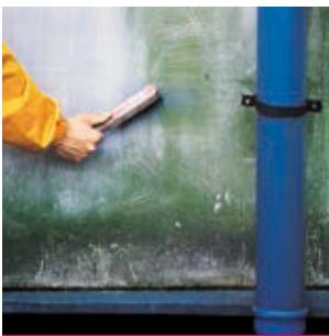
Участки поверхности, покрытые мхами, водорослями или пораженные грибком, следует очистить проволочной щеткой и затем обработать противогрибковым средством Ceresit CT 99 (рис.4).
