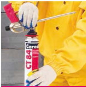
Рис. 11 Присоединение баллона к пистолету
