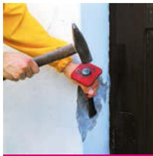
Рис. 2 Удаление непрочных участков основания с помощью зубила
