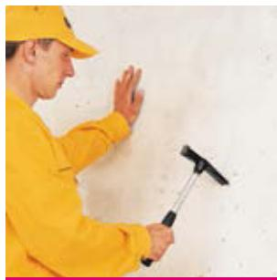
Рис. 1 Удаление непрочных участков основания молотком
