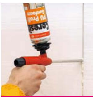
Рис. 19 Заполнение зазоров монтажной пеной
