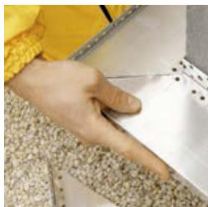
Между соседними профилями необходимо оставлять зазор 2–3 мм длястыковки с помощью пластмассовых соединительных элементов. (рис. 8а).
