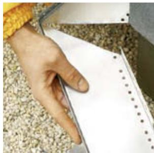
Рис. 8 Монтаж цокольной планки на углах здания
