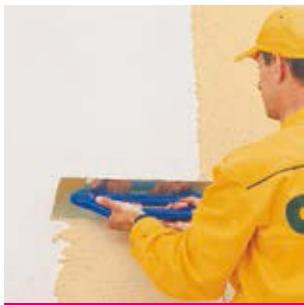
Рис. 45 Нанесение декоративной штукатурки на основание
