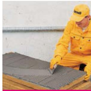
Рис. 14б Минераловатная плита
