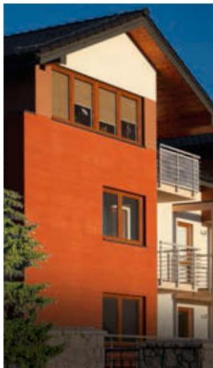
**Система теплоизоляции Ceresit** — это технология наружного утепления фасадов пенополистирольными или минераловатными плитами с отделкой тонкослойными штукатурками.
