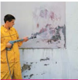
Загрязняющие вещества, а также паронепроницаемые малярные покрытия и покрытия с низкой адгезией к основанию следует полностью удалить, например, струей воды под высоким давлением, механическим способом или с помощью растворителя (рис. 3).
