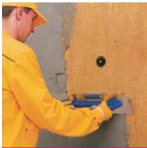
Рис. 38 Грунтование минераловатных плит
