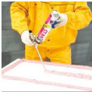
Дополнительно наносят продольную полосу по центру плиты вдоль длинной стороны:
