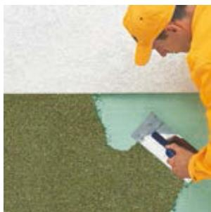
Рис. 50 Нанесение мозаичной штукатурки
