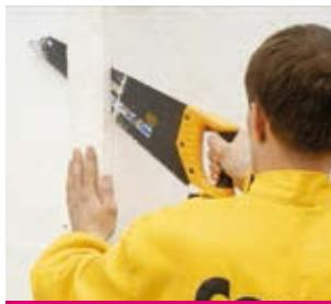
Рис. 25б Пенополистирольная плита
