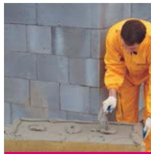
Рис. 13б Минераловатная плита
