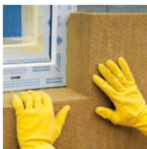
Рис. 22 Порядок расположения плит утеплителя на границе оснований из разнородных материалов
