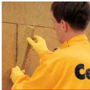
Рис. 18 Заделка открытых швов
