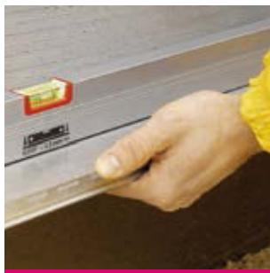
Рис. 7а Установка горизонтального положения при помощи уровня
