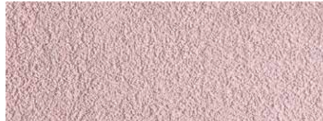
Штукатурка Ceresit СТ 72, зерно 1,5 мм, получена путем затирания пластиковым полутерком (теркой).
