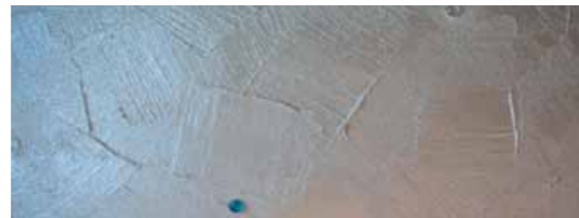
Штукатурка Ceresit СТ 36, фактура получена путем нанесения тонким металлическим шпателем.
