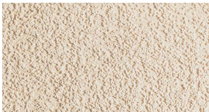
Штукатурка Ceresit СТ 137, зерно 2,5 мм, получена путем затирания пластиковым полутерком (теркой).
